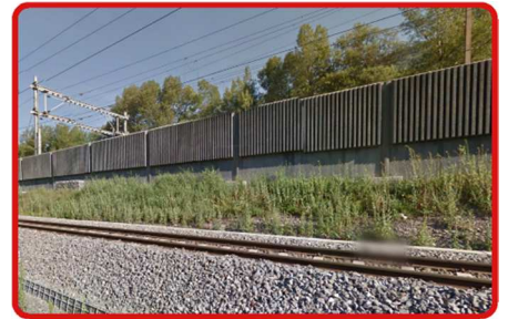
LSW Brig-Ried, Termen Länge 692m Baujahr 2013 Bauherrschaft ASTRA
