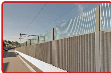
LSW Gemeinde Freienbach Länge 925m Baujahr 2014 Bauherrschaft SBB Zürich
