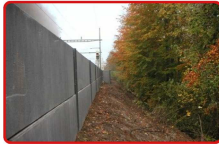
LSW Gemeinde Chiasso Länge 531m Baujahr 2014 Bauherrschaft SBB Bellinzona
