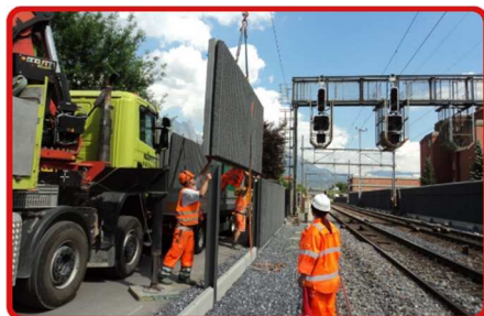
LSW Sargans, Quarten Longeur 400m Année de construction 2012 Maîtrise d'ouvrage CFF Zurich
