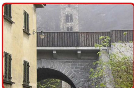
LSW Chiggiogna-Anzonico Longeur 349m Année de construction 2012 Maîtrise d'ouvrage CFF Bellinzona
