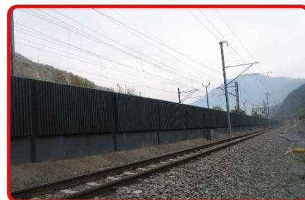
LSW Visp-St. German Longeur 160m Année de construction 2013 Maîtrise d'ouvrage CFF Lausanne
