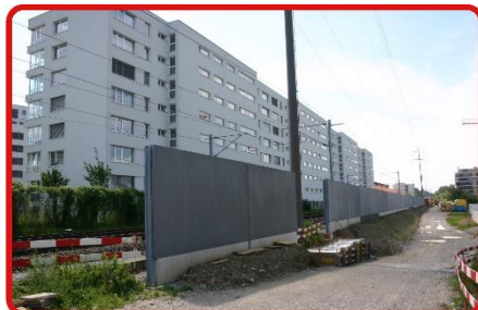
LSW comune Uster Lunghezza 150m Anno di costruzione 2012 Costruttore FFS Zurigo
