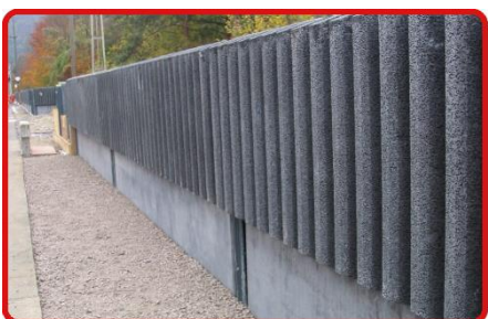
LSW Wollerau Lunghezza 158m Anno di costruzione 2012 Costruttore FFS Zurigo
